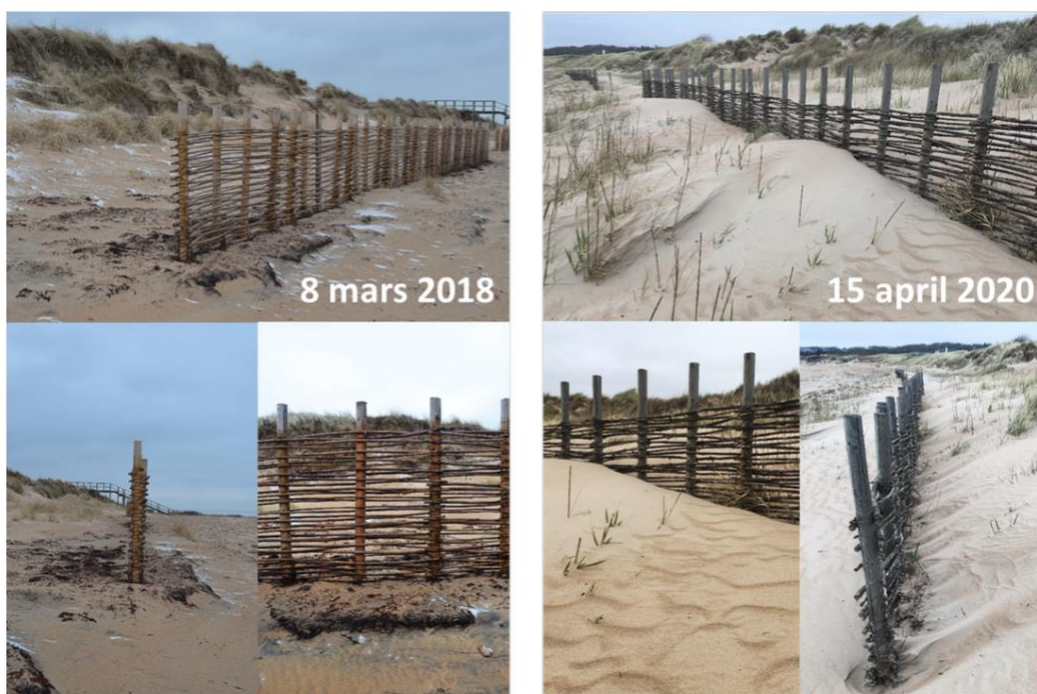
Sandstaket jämfört mellan 2018 och 2020. Två år efter anläggande har betydande sandmängder samlats och vegetation återetablerats. Exempel från Ängelholm.
